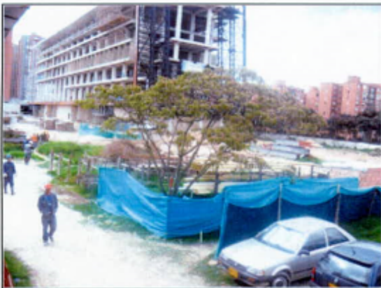
Foto No. 1. Panorámica del proyecto y campamento.
