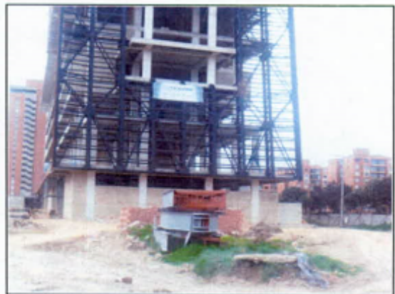
Foto No. 2. Zona Frontal del Proyecto, fachada en estructura metálica.
